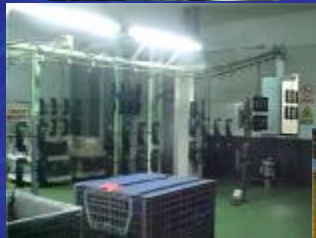
§ Inyección por gas
